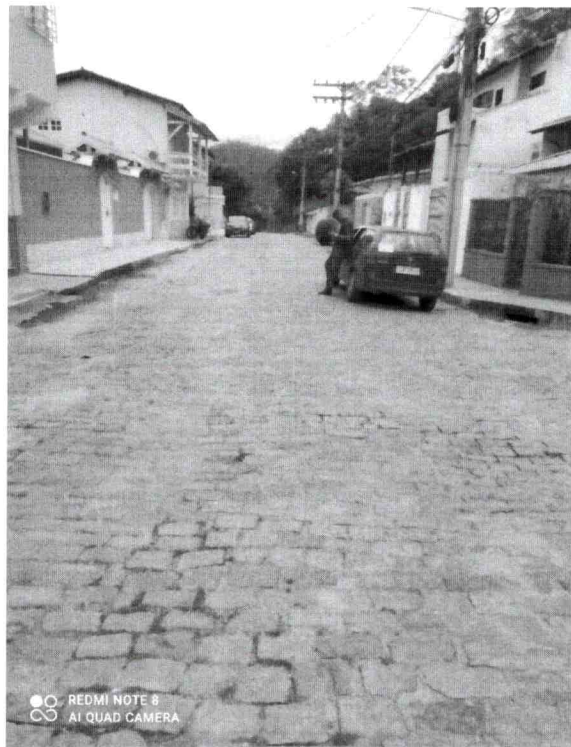
Foto 03/06 (Vista da continuidade da Rua Cristiano Ribeiro Filho)
